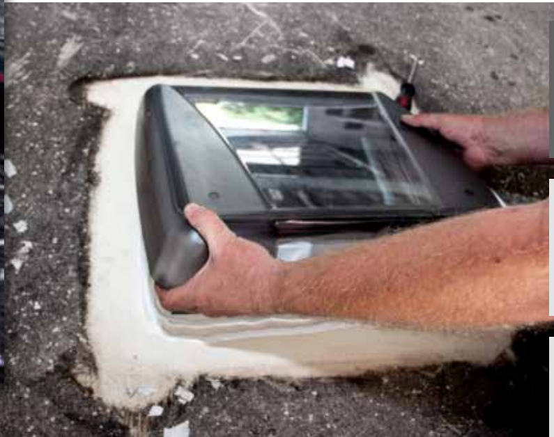
Adhesión de una ventana de techo (Foodtruck) Flex 310 PU
